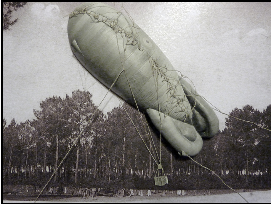
Mise en place de la nacelle...
